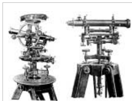
Teodolit a nivelační přístroj značky Frič.
